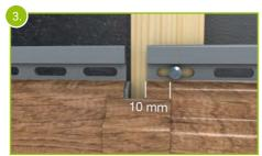
Fügen Sie nun die Fassadenprofile zusammen. Stellen Sie sicher, dass die Profile gemäß den Angaben der Montageanleitung mittig durch eine Schraube zwischen 2 Langlöchern fixiert sind. Die Breite der Dehnfuge muss 10 mm betragen (siehe Bild).
