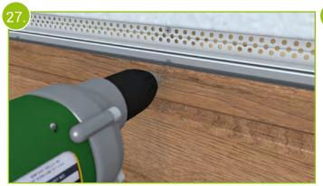
Das gekürzte, obere Fassadenprofil wird ca. 10 mm unterhalb der Sägekante im Abstand von 30 cm auf Höhe der Traglatten vorgebohrt.
