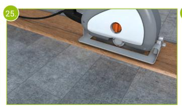
Die Kürzung kann problemlos mit Hilfe einer Stichsäge oder Handkreissäge erfolgen.
