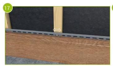
Die Verschraubung der Fassadenprofile mit der Traglattung erfolgt mittig durch die in den Federbereichen eingebrachten Langlöcher mittels der Fassadenschrauben.
