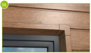
Die Fensterleibungen können bei Bedarf zusätzlich mit Dekodeck-Hartschaumwinkeln ausgekleidet werden. Sie können die Hartschaumwinkel vollflächig verkleben oder verschrauben.
