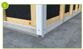
Verschrauben Sie nun die Unterteile der 90 Grad - Außeneckprofile in allen Eckbereichen im Abstand von 40 cm entlang der eingebrachten Schraubnuten. Hierzu muss die Auflagefläche der Unterteile vorher vollflächig durch zusätzliche Traglatten aufgefüttert werden.
