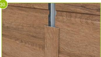
Montieren Sie das Oberteil des 2-teiligen Verbindungsprofils exakt gleich, wie das des Eckprofils.
