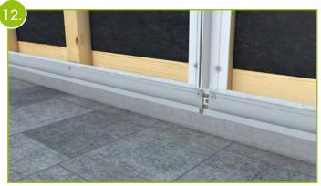
Fixieren Sie das Aluminium-Startprofil nun bündig mit der Unterkante des unteren Lüftungsprofils entlang des unteren Fassadenabschlusses mit Hilfe der eingebrachten Schraubnut. Achtung: Im Bereich der Verbindungsprofile müssen die Startprofile geteilt werden!
