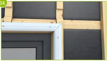
Montieren Sie die Unterteile der 2-teiligen Abschlussprofile bündig entlang der Fensterleibung. Die Eckverbindungen erfolgen per Gehrungsschnitt. Zur vollflächigen Auflage der Unterteile muss die Traglattung horizontal aufgefüttert werden.
