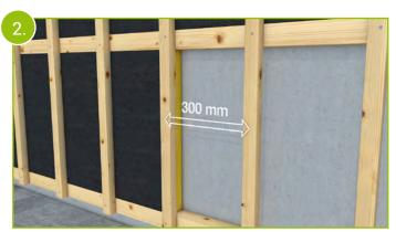
Bei der optionalen Verwendung von Dämmmaterial erfolgt das Anbringen der Traglatten als Konterlattung ebenfalls im Abstand von 30 cm.
