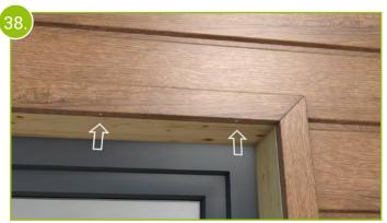
Im Bereich oberhalb des Fensters oder der Tür müssen im Abstand von 20 cm Entwässerungslöcher mit Durchmesser 6 mm im Abschlussprofil eingebracht werden, um einen ordnungsgemäßen Ablauf von Regenwasser sicherzustellen.
