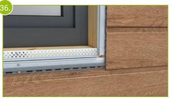
Klinken Sie Fassadenprofile in den Bereichen der Fensterleibungen am unteren und oberen Bereich der Fenster und Türen mit Hilfe einer Stichsäge aus.
