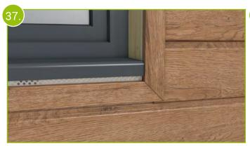
Sägen Sie nun die Oberteile der Abschlussprofile und des Lüftungsprofils zu (incl. Gehrungsschnitten) und klipsen diese auf die bereits montierten Unterteile. Bitte berücksichtigen Sie bei der Länge der Oberteile eine mögliche Profilausdehnung von ca. 3 mm pro Meter!
