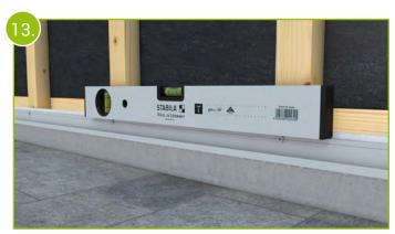
Achten Sie bei der Montage des Aluminium-Startprofils bitte auf eine exakte, horizontale Ausrichtung!
