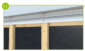
Verschrauben Sie nun das Unterteil des oberen Lüftungsprofils entlang des oberen Fassadenabschlusses gemäß der Skizze mit Hilfe der im Profil eingebrachten Schraubnut. Bei Fassadenverkleidungen incl. Fensterelementen siehe auch Abbildung 35!
