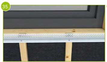
An der Unterseite der Fensterbank verschrauben Sie ein Unterteil des 2-teiligen, oberen Lüftungsprofils, damit auch in diesem Bereich eine Entlüftung gewährleistet ist.
