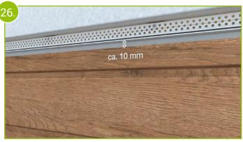
Der Abstand der Sägekante zur Klipsnut des oberen Lüftungsprofils sollte ca. 10 mm betragen.
