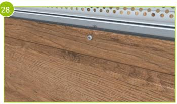
Anschließend wird das Fassadenprofil mit den Fassadenschrauben entsprechend fixiert.
